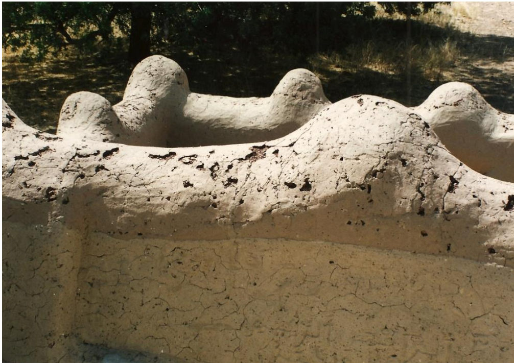
das obere Ende der an der Basis 1,5 bis 2 Meter breiten Moschee-Mauern 10
