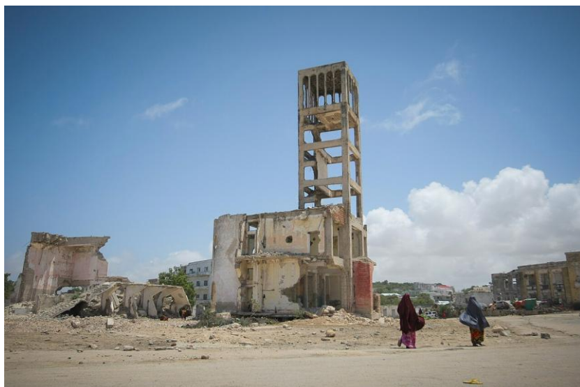
Mitte 2013, zwei Jahre nach dem Abzug der Al-Shabaab aus Mogadishu: Ausgebombte Gebäude im Boondheere-Bezirk Mogadishu 18
