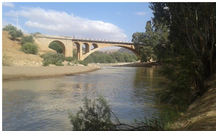
Brücke über den Oued Beht, etwa 100 km östlich von Rabat 1
