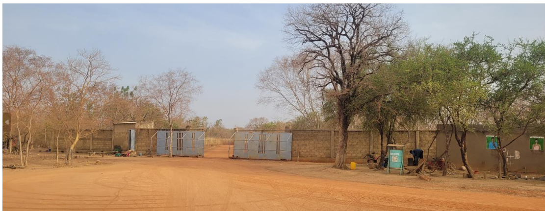
ganz massive Mauern...
