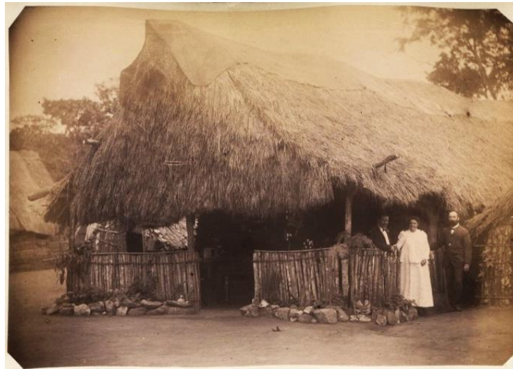
Olokos Distrikt-Ingenieur mit Frau vor seiner Residenz 4
