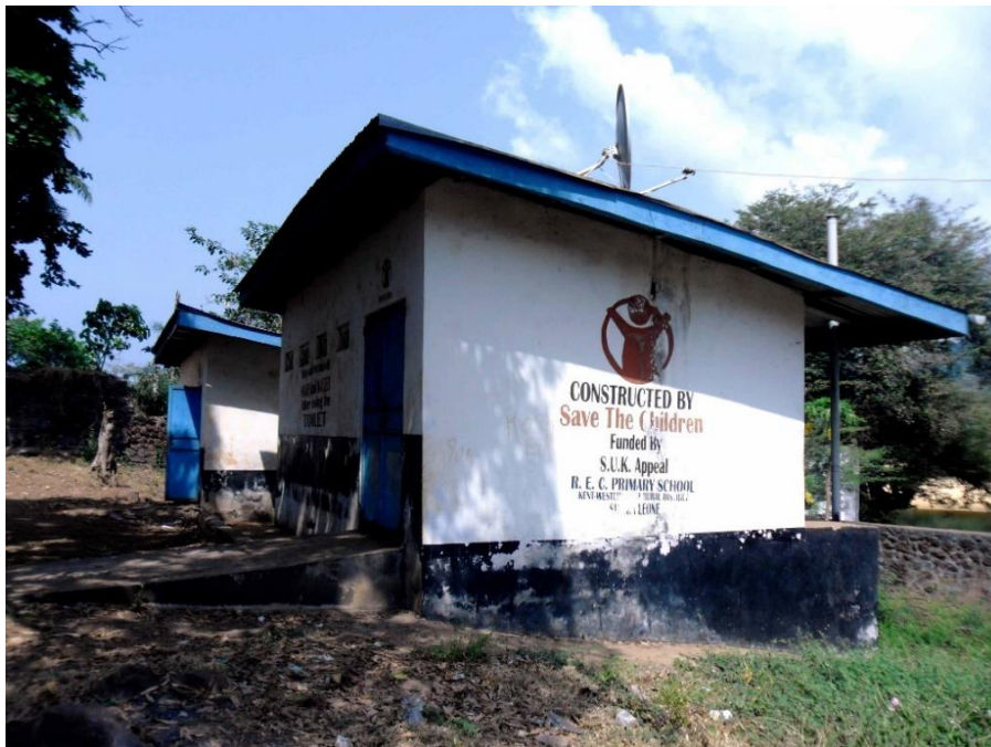
Toilettenanlage einer Schule in Kent (an der Südspitze der großen Halbinsel, auf der im Norden Freetown liegt), von einer großen internationalen NGO gebaut; neben der Eingangstüre steht, dass aufs Händewaschen mit Seife nicht vergessen werden soll 34
